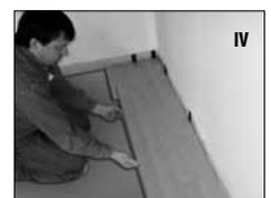
côté long dans la rainure du premier morceau de la rangée (IV). Rapprochez les joints jusqu'à ce qu'ils soient distants d'environ 6 mm (1/4 po). Cliquez maintenant la planche en place dans le sens de sa longueur. Pour le bord court et le bord long, au besoin, utilisez le bloc de tapement et tapez quelques petits coups jusqu'à ce que les planches s'enclenchent complètement.
