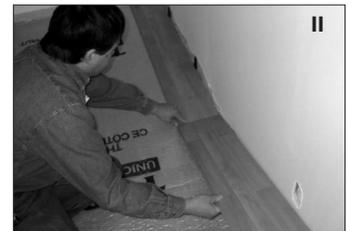
Le morceau coupé de la première rangée devient la première planche d'une autre rangée. Installer le bord coupé face au mur, avec la cale de séparation en place. Ce morceau est maintenant prêt à être cliqué dans la première planche de la première rangée. Les morceaux coupés devraient être de 12" (30 cm) minimum de longueur (III).
