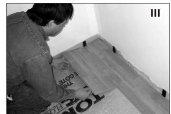
En continuant la deuxième rangée avec un plein morceau, placer la languette du côté long dans la rainure du morceau de la première rangée (IV). Déplacer le bord court jusqu'à ce qu'il soit poussé contre la plancher précédente avant de l'abaisser. La planche doit s'enclencher dans la première rangée et le joint d'extrémité être logé fermement dans la planche précédente.
