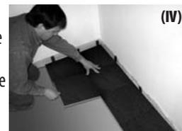
Vous ne devriez pas tenter de frapper le joint Uniclic d'un seul coup. Continuez ainsi, carreau par carreau, sur toute la largeur de la pièce. Les derniers carreaux de chaque rangée sont coupés de façon à assurer un espacement de 10 mm (3/8 po) avec le mur.
