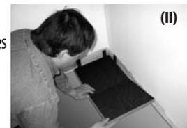
Le carreau coupé de la première rangée devient le premier carreau de la deuxième rangée, ceci créera un joint décalé (III). Le bord coupé est installé face au mur, avec la cale de séparation en place. Inclinez ensuite ce carreau et endenchez-le dans le premier carreau de la première rangée. Les carreaux coupés devraient être d'au moins 20 cm (8po) de longueur.
